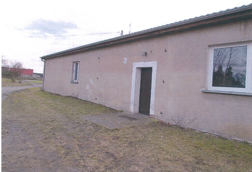
fotografia2. Świetlica wiejska w Gralewie (źródło: UMiG Międzychód)
