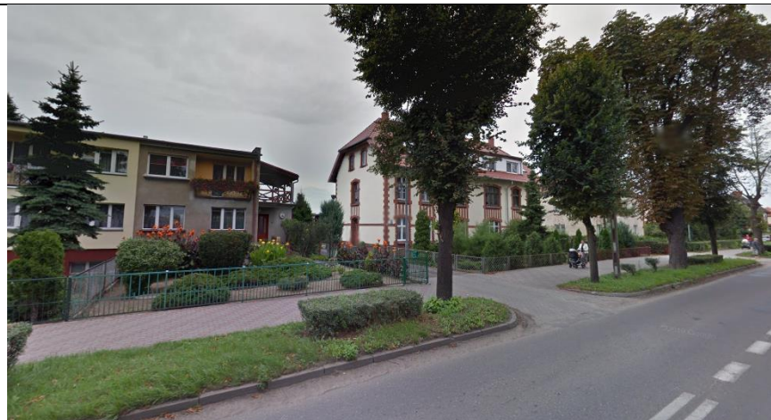
Fot. 2. Widok na budynki mieszkalne znajdujące się po północnej stronie ul. Generała Sikorskiego
