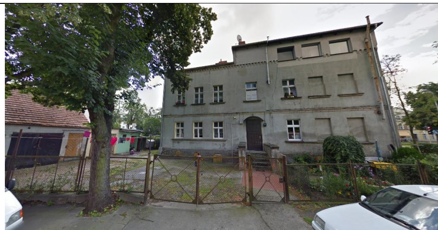
Fot. 2. Widok na budynek mieszkalny znajdujące się po zachodniej stronie ul. Kościelnej
