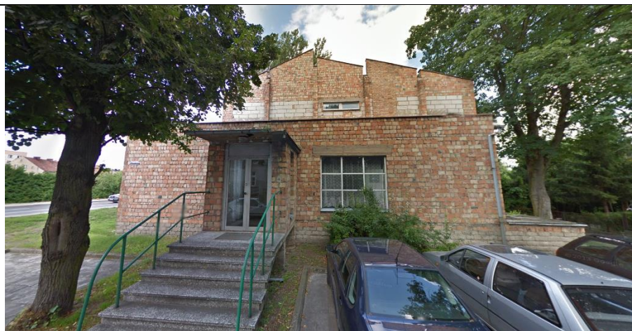
Fot. 1. Widok na budynek znajdujący się na dz. nr 288/1 od strony ul. Kościelnej
