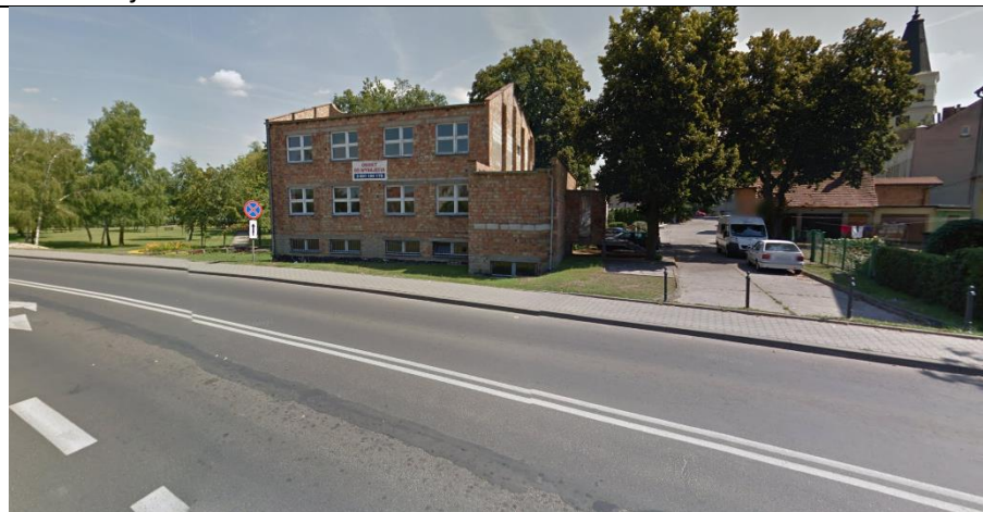
Fot. 3. Widok na budynek znajdujący się na dz. nr 288/1 od strony ul. Czynu 600-lecia
