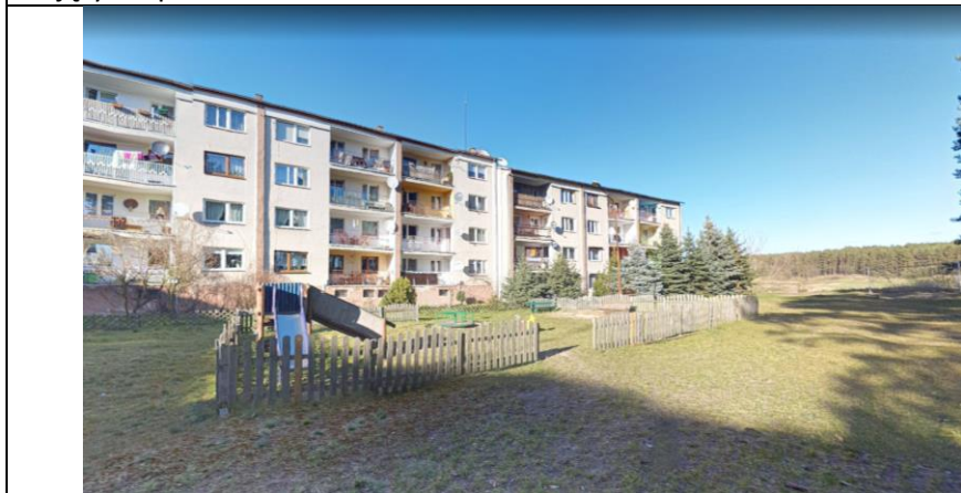
Fot. 3. Widok na plac zabaw zlokalizowany na obszarze objętym opracowaniem
