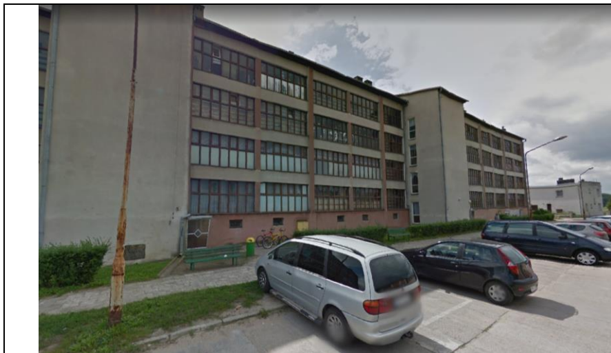
Fot. 1. Widok budynek mieszkalny wielorodzinny zlokalizowany na obszarze objętym opracowaniem
