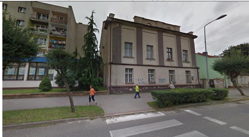
Fot. 4. Widok na budynek mieszkaniowy wielorodzinny znajdujący się po przeciwległej stronie ul. 17 Stycznia
