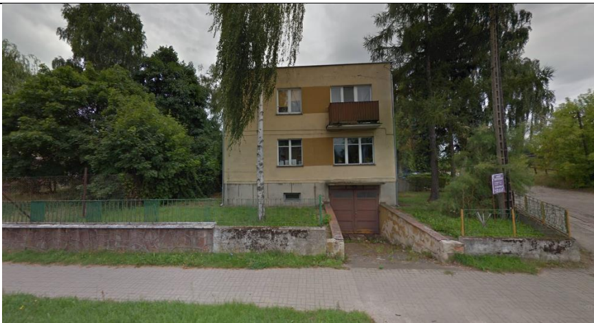
Fot. 1. Widok na budynek przychodni lekarskiej od strony ul. Generała Sikorskiego
