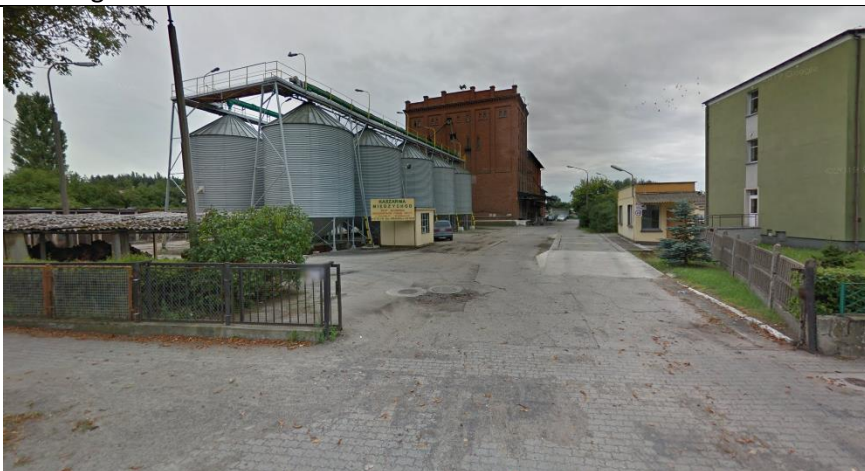
Fot. 3. Widok na budynek młyna parowego objętego gminną ewidencją zabytków od strony ul. Generała Sikorskiego
