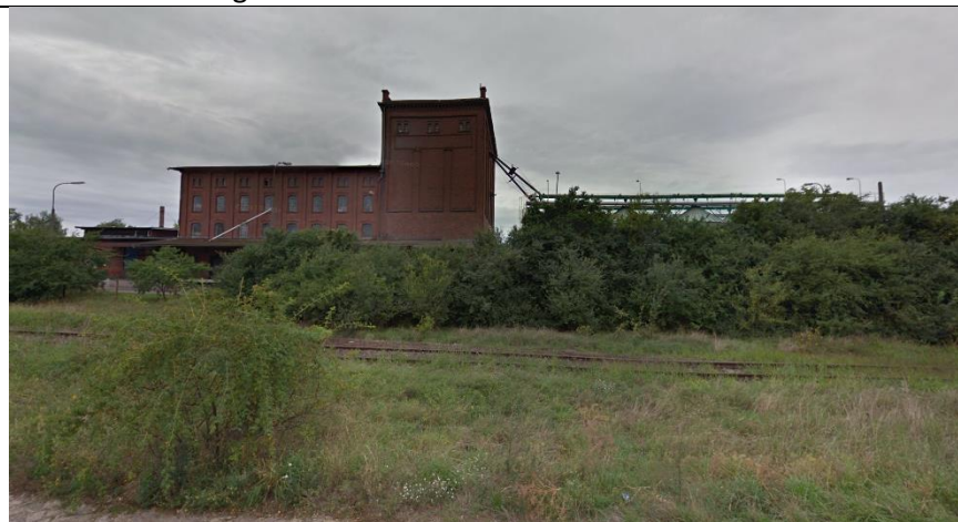
Fot. 4. Widok na budynek młyna parowego objętego gminną ewidencją zabytków od strony ul. Dworzec Letnisko
