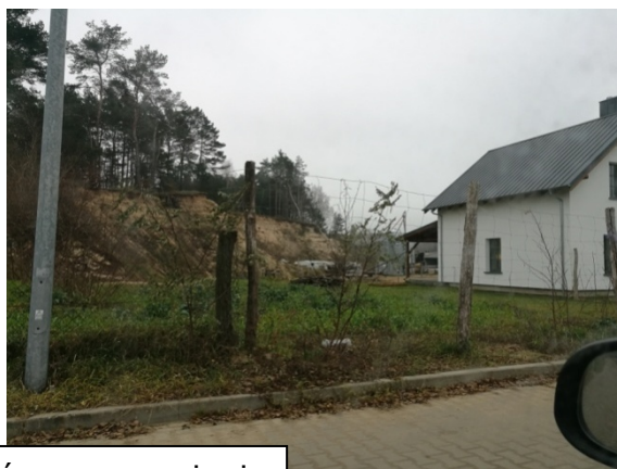
Podcięte skarpy leśne - zagrożenie osuwaniem się mas ziemnych
