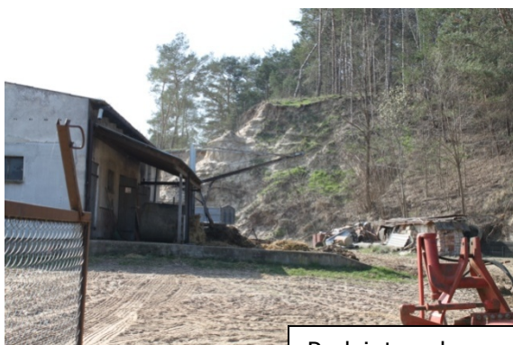
Podcięte skarpy leśne - zagrożenie osuwaniem się mas ziemnych
