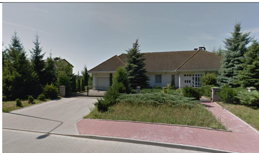
Fot. 2. Widok na budynek mieszkalny jednorodzinny od ul. Hubała
