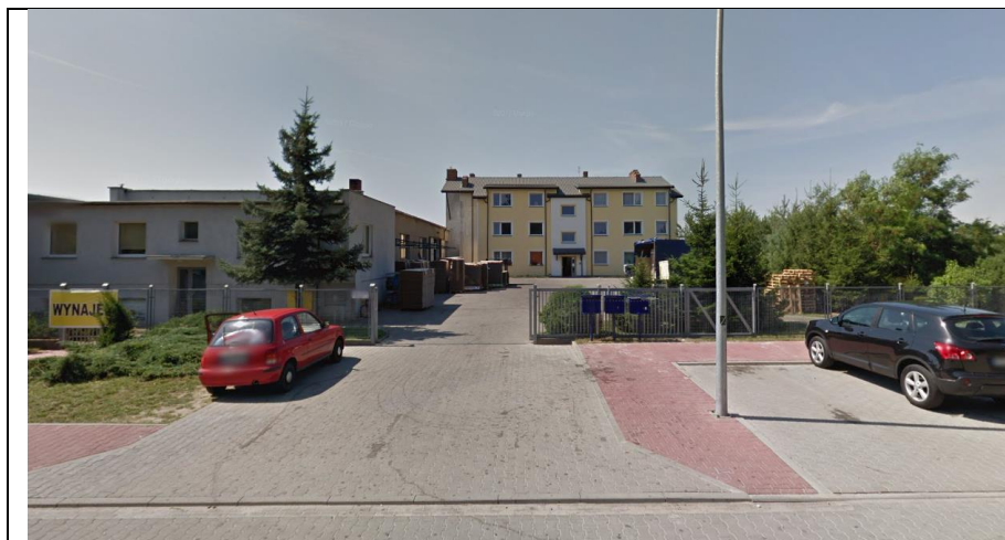
Fot. 1. Widok na budynek wielorodzinny i obiekt usługowo – magazynowy od ul. Hubała
