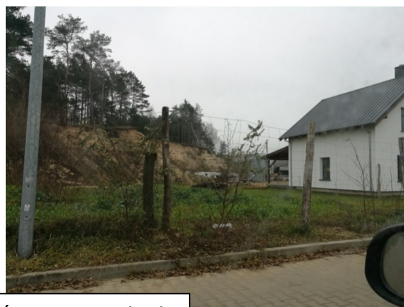
Podcięte skarpy leśne - zagrożenie osuwaniem się mas ziemnych
