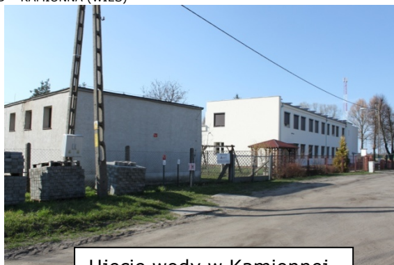
Ujęcie wody w Kamionnej
